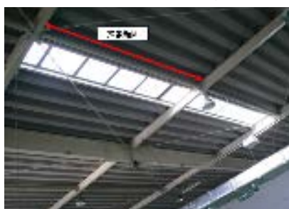
照度向上 8月 天井の採光拡大により照度向上 (本社倉庫開墾場)
