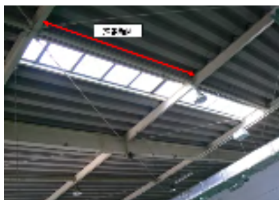
照度向上 8月 天井の採光拡大により照度向上 （本社倉庫開墾場）
