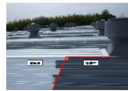
室内温度抑制 6月 セラミック断熱ガイナ塗装 施工 (本社倉庫屋根)
