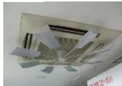
空気循環効率アップ 6月 エアコンファンの取り付け (事務所)
